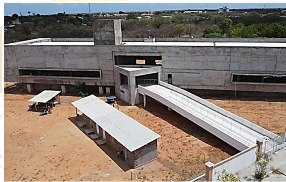
FIGURA 81 - OBRA EM ANDAMENTO DO CENTRO DE INOVAÇÃO TECNOLÓGICA E EMPREENDEDORISMO DO SEMIÁRIDO
