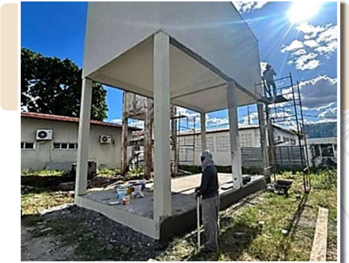
FIGURA 79 - CONSTRUÇÃO DO RESERVATÓRIO ELEVADO DO LASAP
