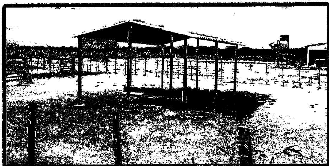
Figura 8 – Setor da Caprinocultura. Estrutura de pátio. Telhado de fibrocimento, pilares, estacas e portões de madeira e grades. Fonte: PROAD/PROPLAN/UFERSA. Foto tirada em agosto de 2019.
