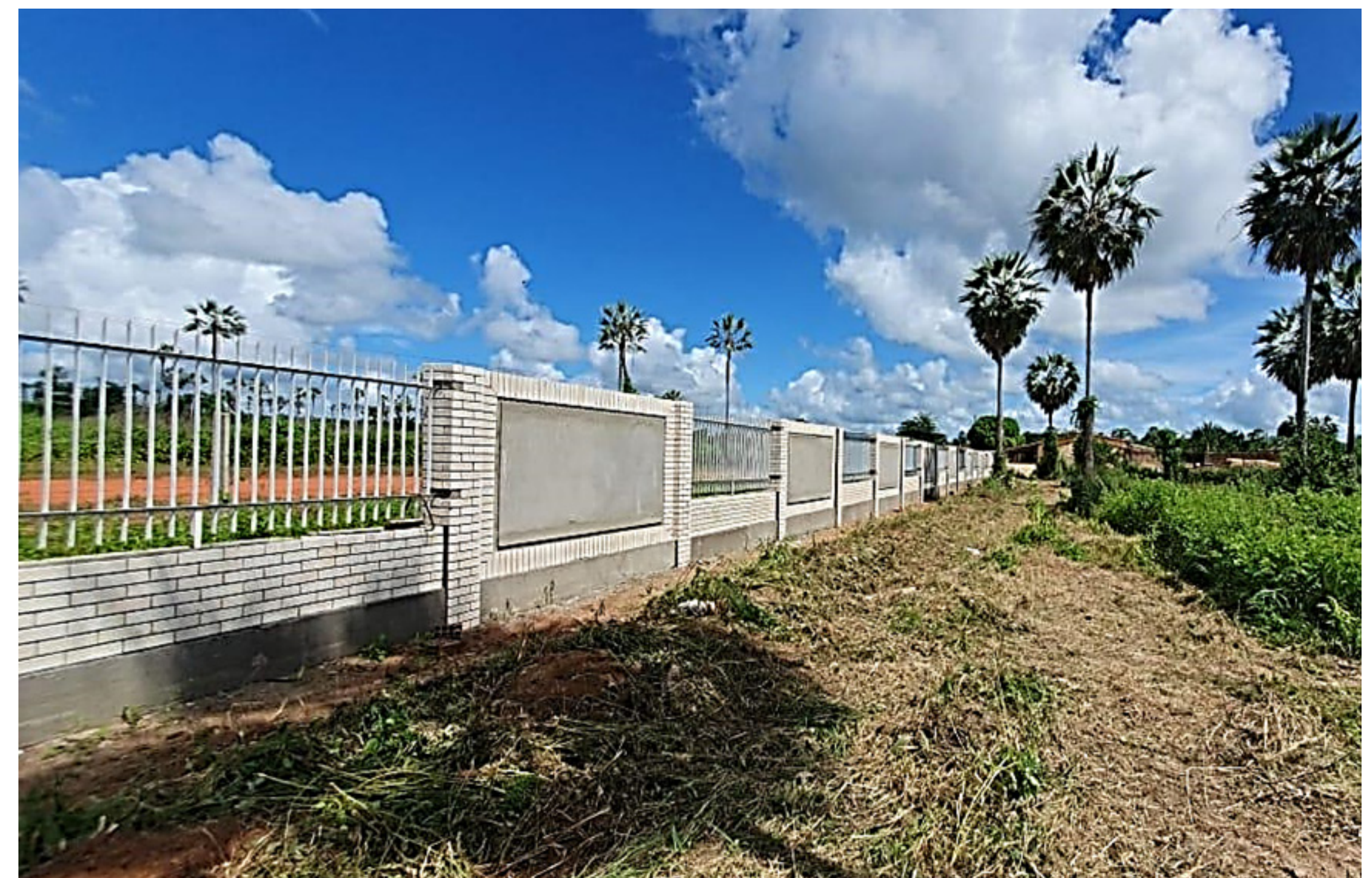
Figura 61 - Muro da Fazenda Experimental na comunidade de Lagoinha em Mossoró
