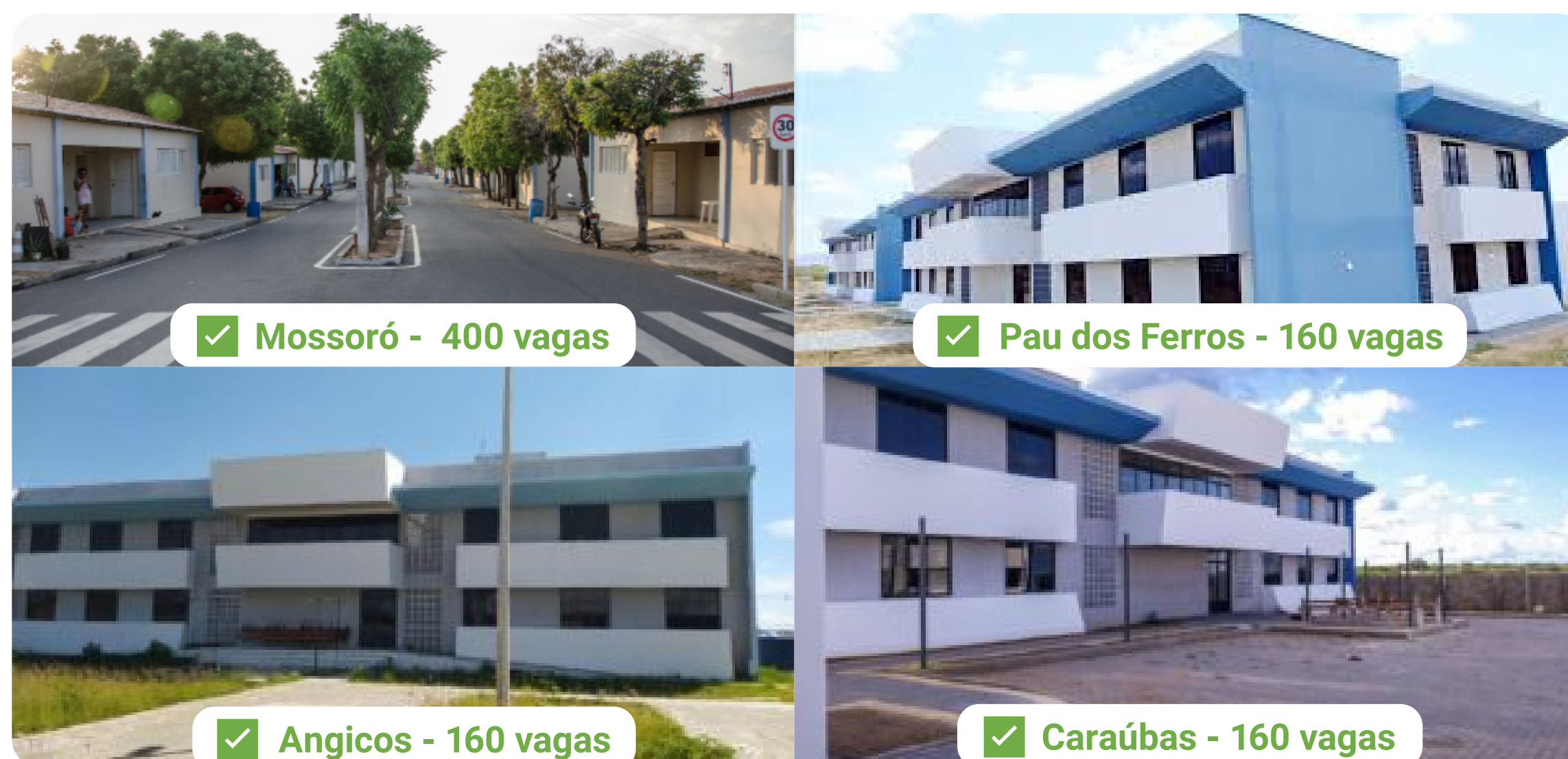
Figura 45 - Imagens das moradias estudantis da Ufersa.
