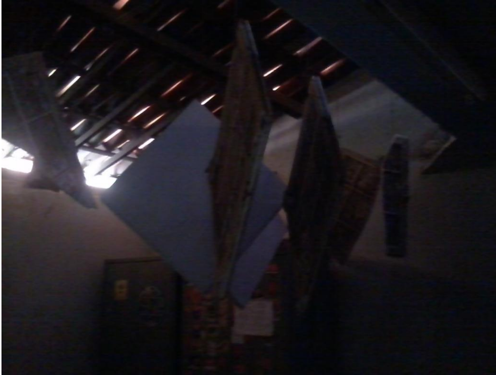
FOTO 8 – Desabamento de placas de gesso
