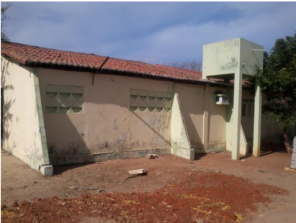
FOTO 3 – Fachada Lateral Direita
