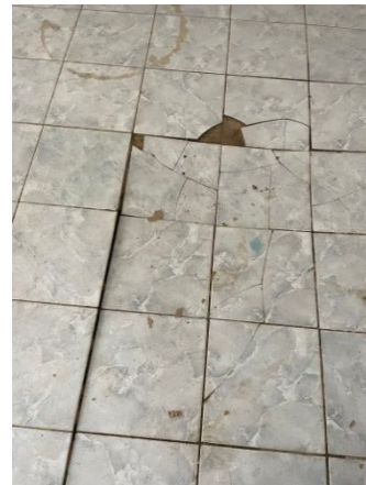
Figura 8 – Piso danificado
