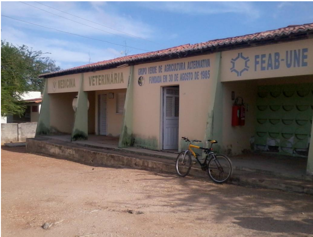
FOTO 5 – Fachada Lateral Esquerda
