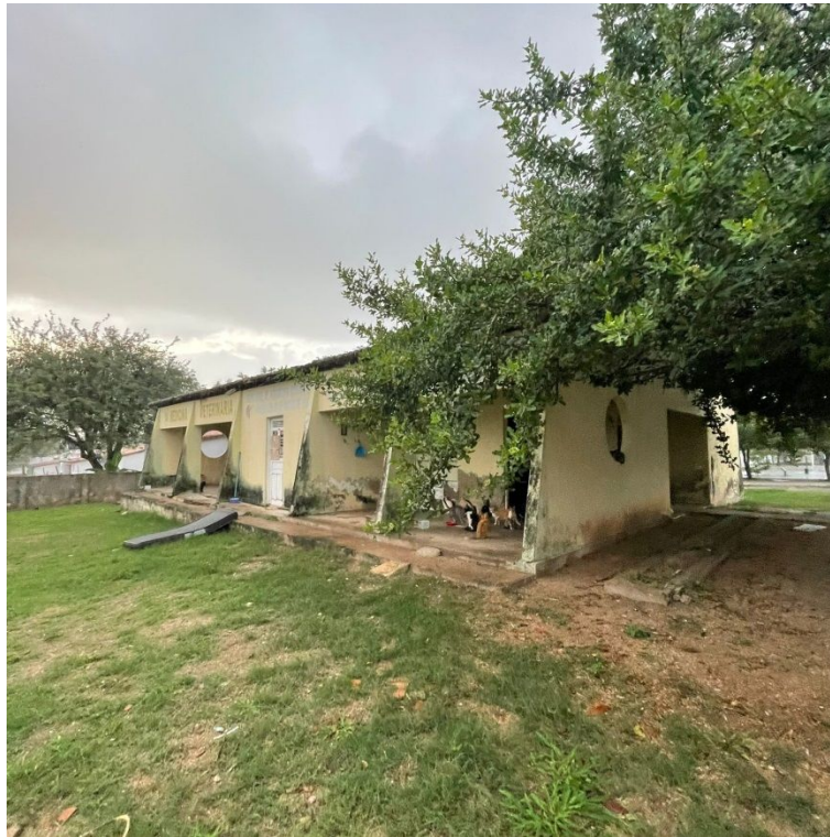
Figura 2 – Edificação em desuso. Antiga sede dos Centros Acadêmicos da UFERSA.
