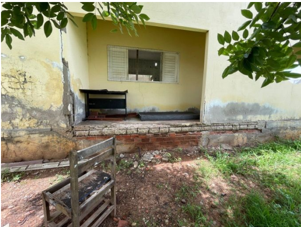
Figura 7 – Fachada da edificação
