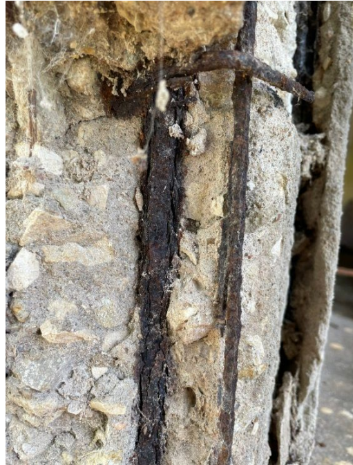
Figura 6 – Pilar danificado
