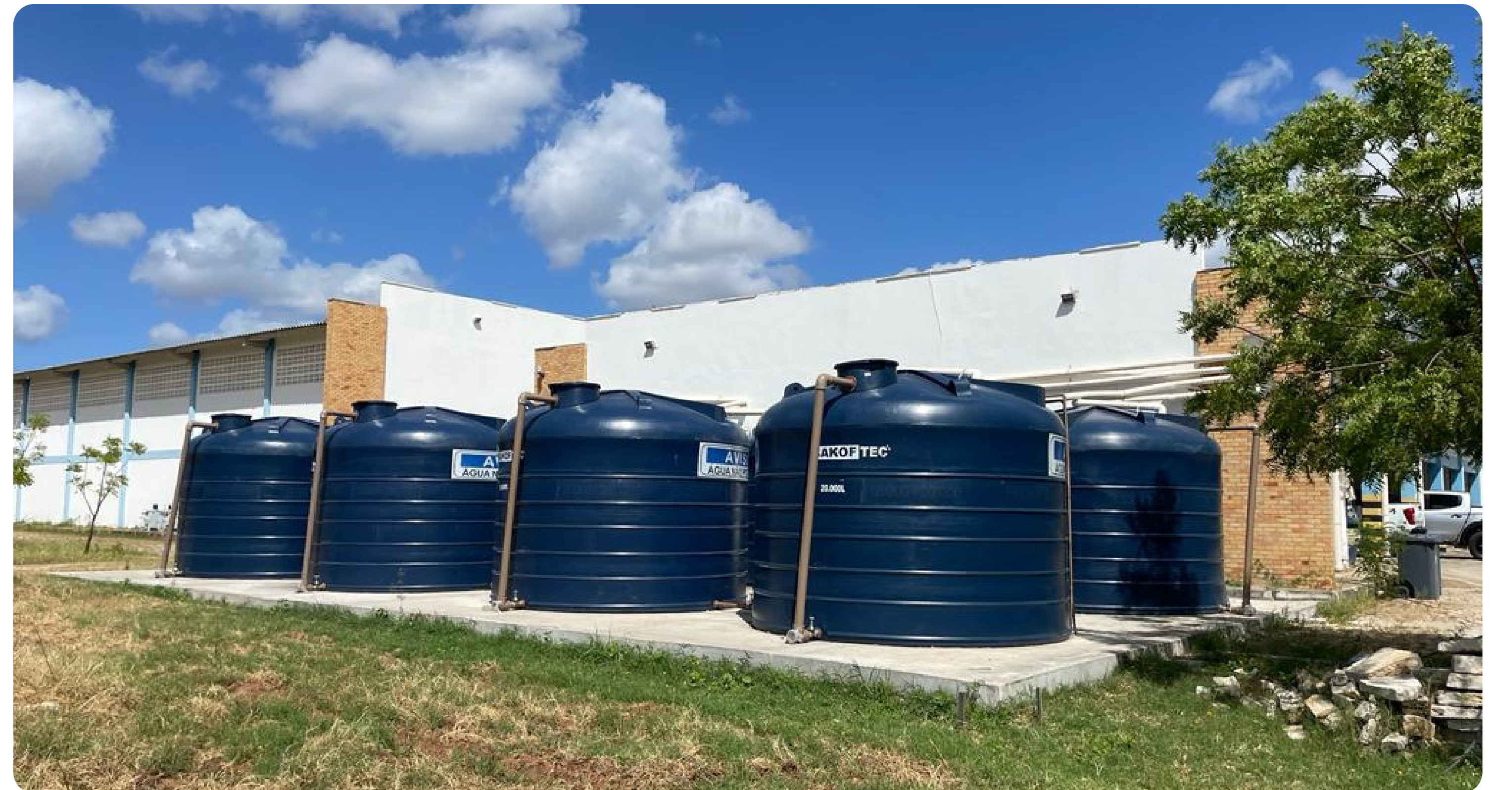
Figura 55 Sistema de reuso de águas pluviais.
