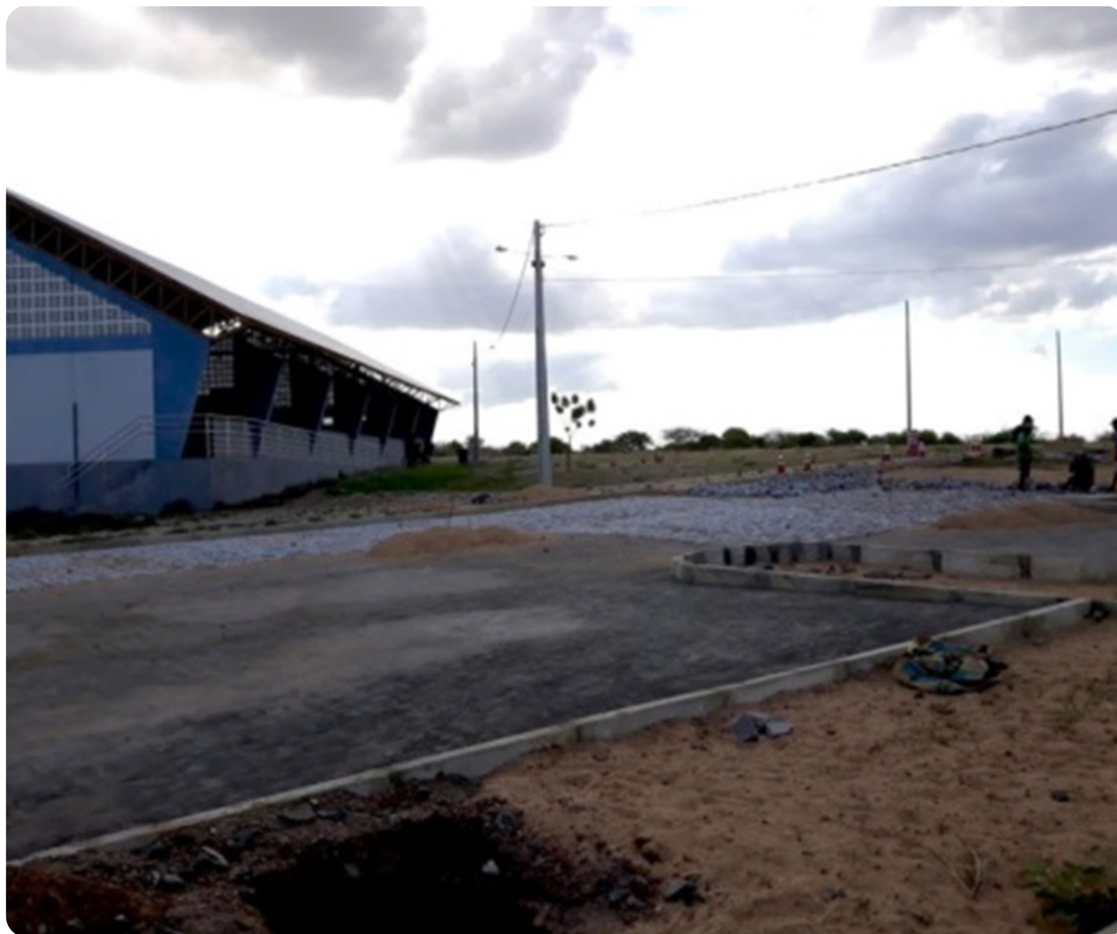
Figura 58 Urbanização de acesso à quadra poliesportiva no Campus Angicos
