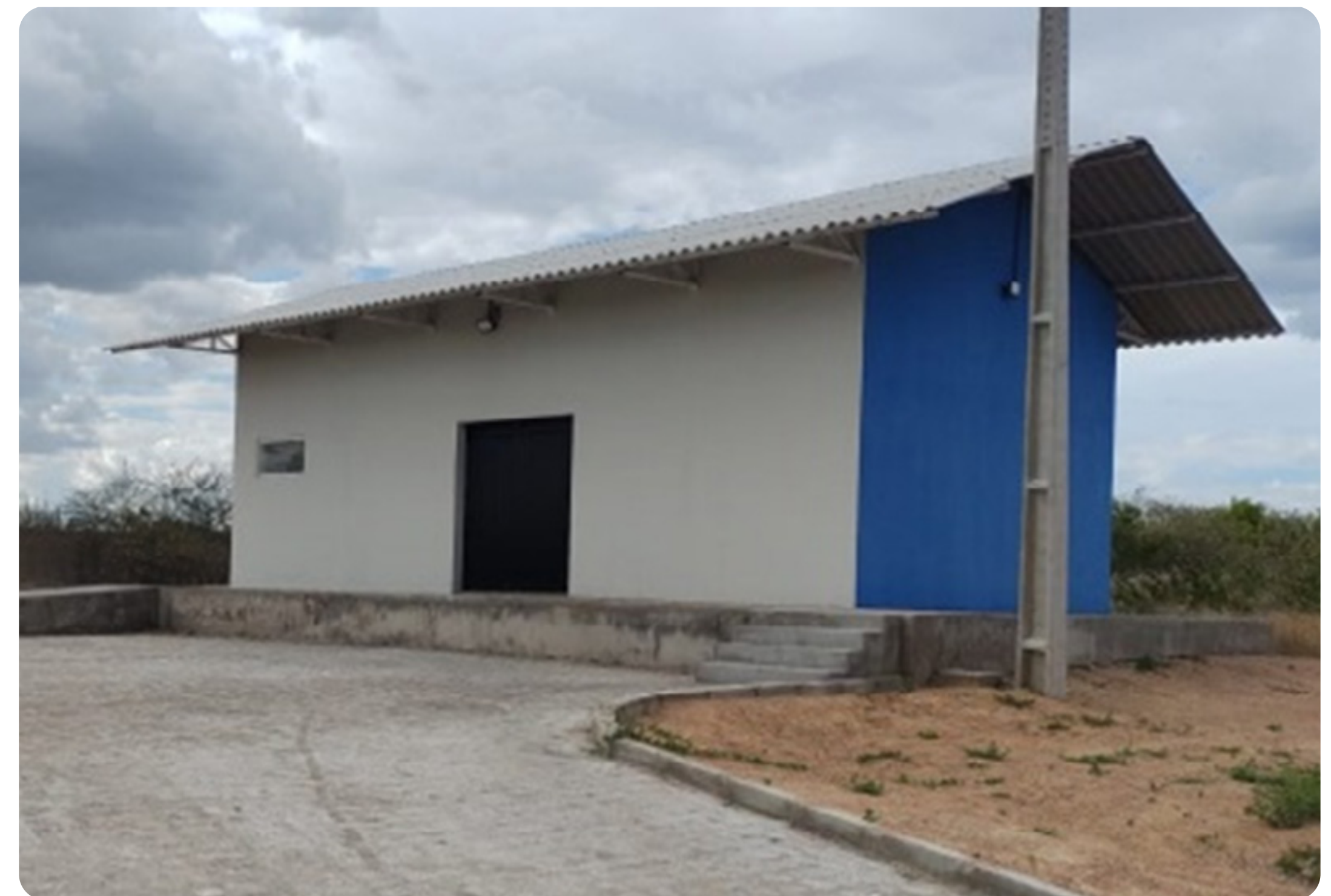
Figura 50 Abrigo de Resíduos em Caraúbas.
