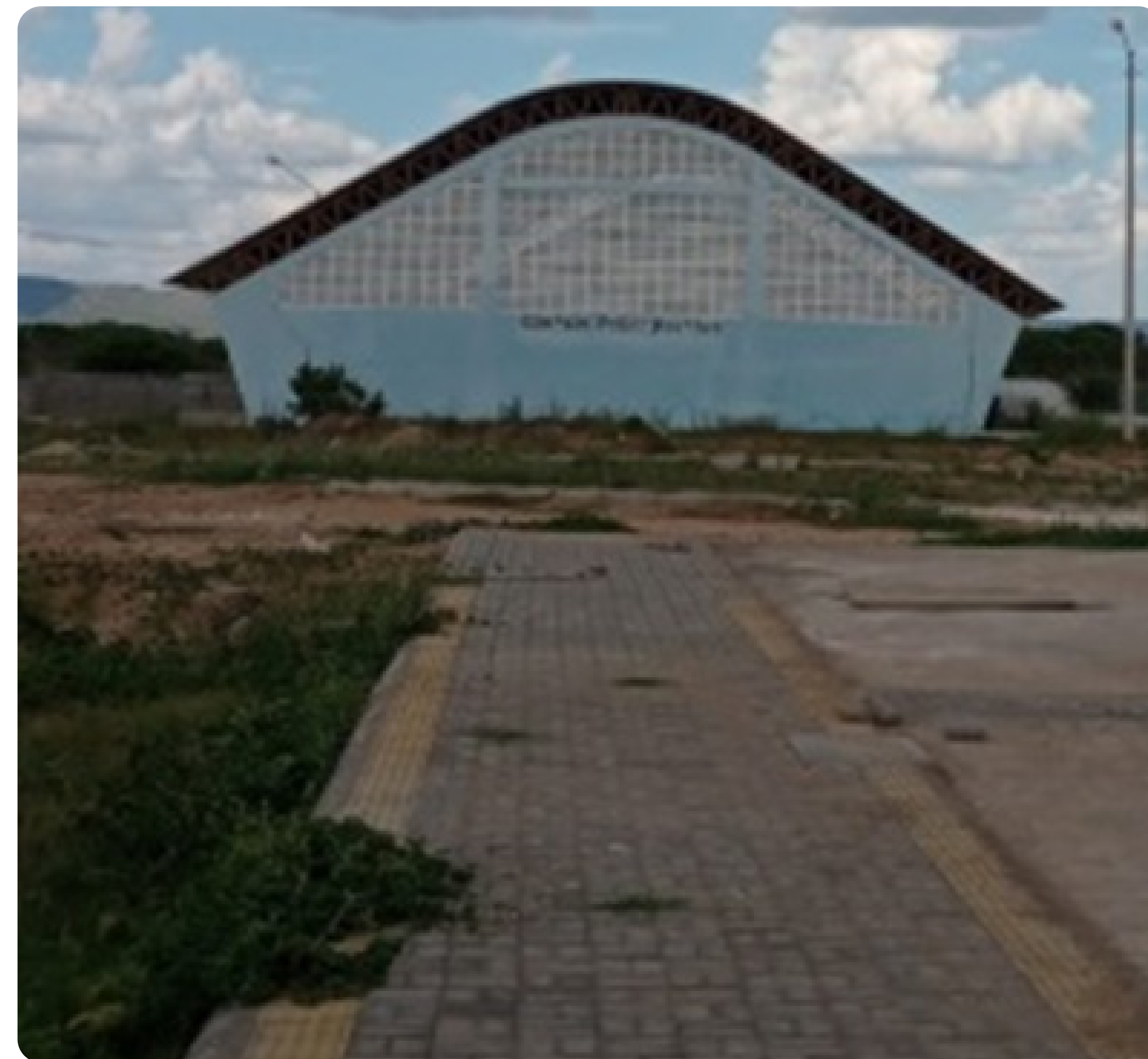
Figura 59 Urbanização de acesso à quadra poliesportiva no Campus Pau dos Ferros .
