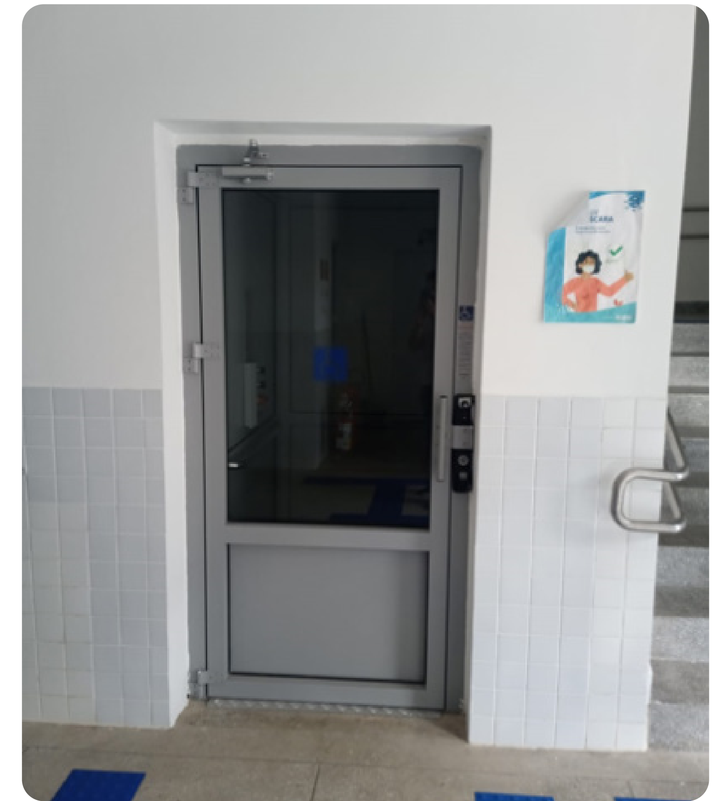
Figura 53 Instalação de Plataforma de acessibilidade no Campus de Pau dos Ferros.
