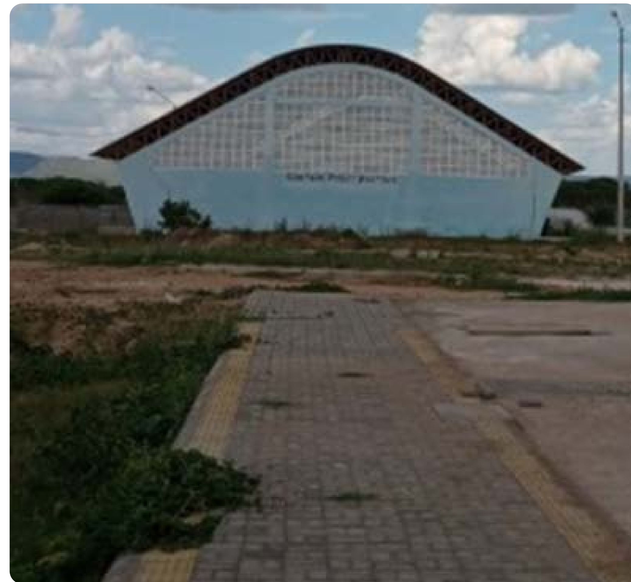
Figura 54 Urbanização de acesso à quadra poliesportiva no Campus Pau dos Ferros .
