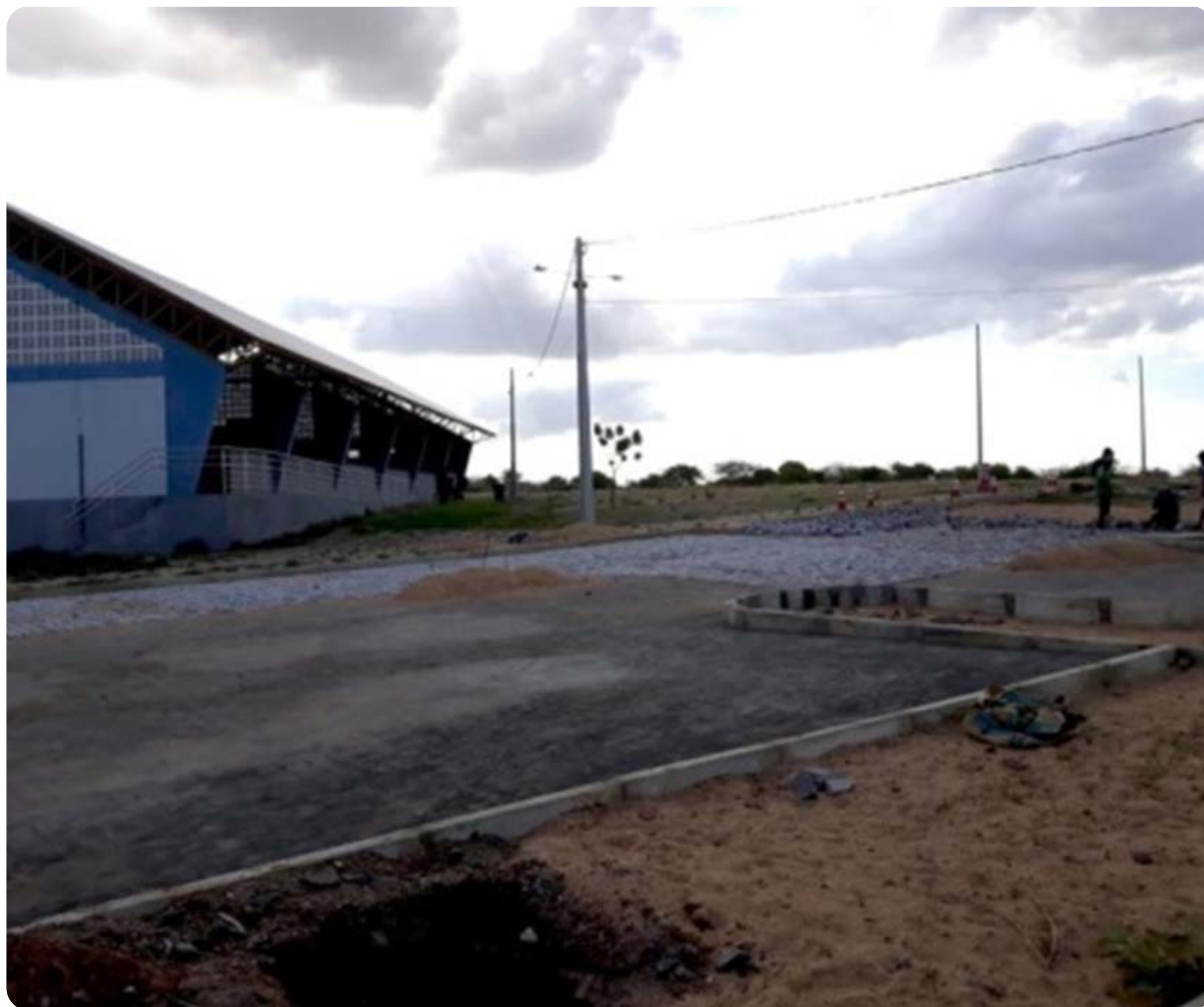
Figura 53 Urbanização de acesso à quadra poliesportiva no Campus Angicos
