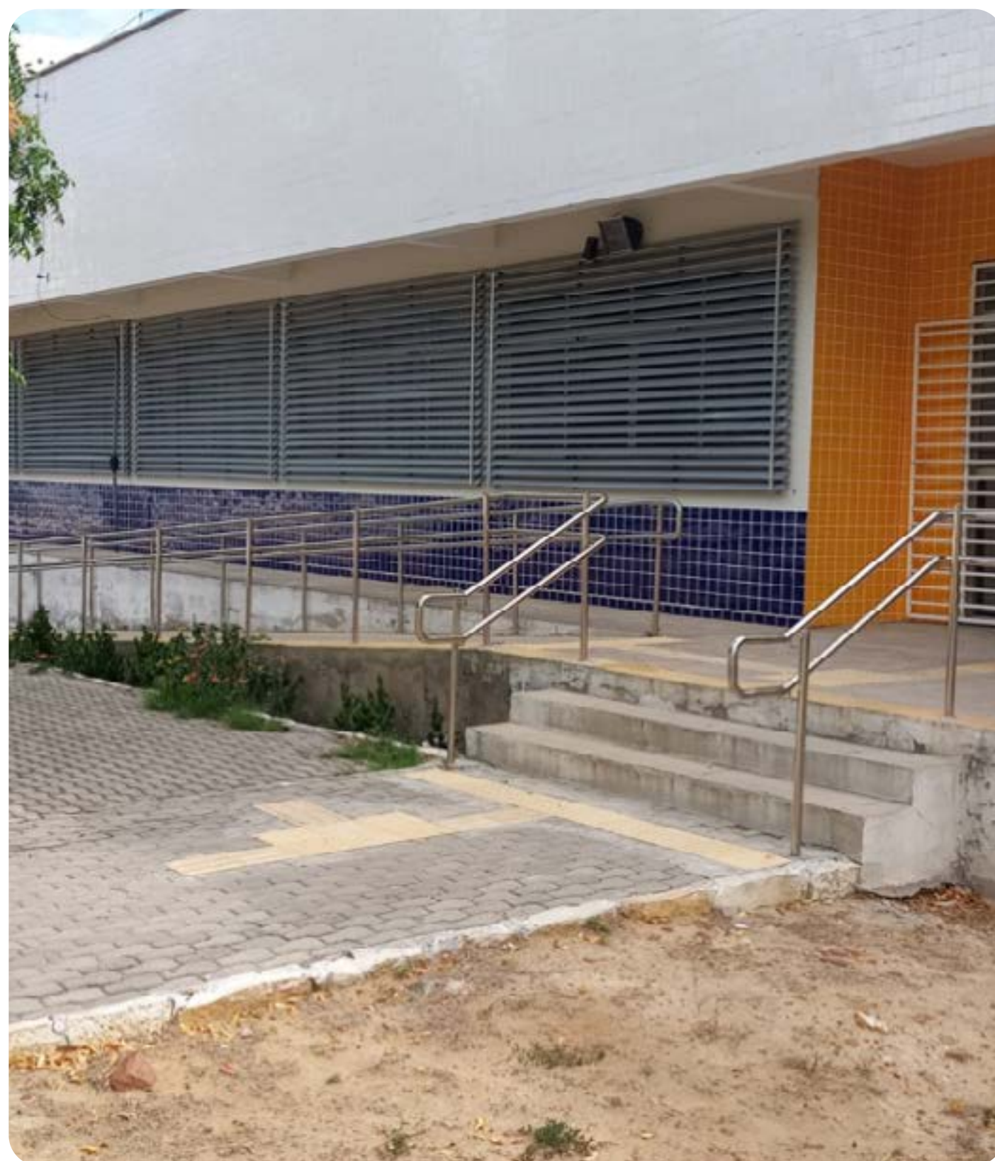
Figura 46 Instalação de Corrimão em prédios do Campus de Angicos.
