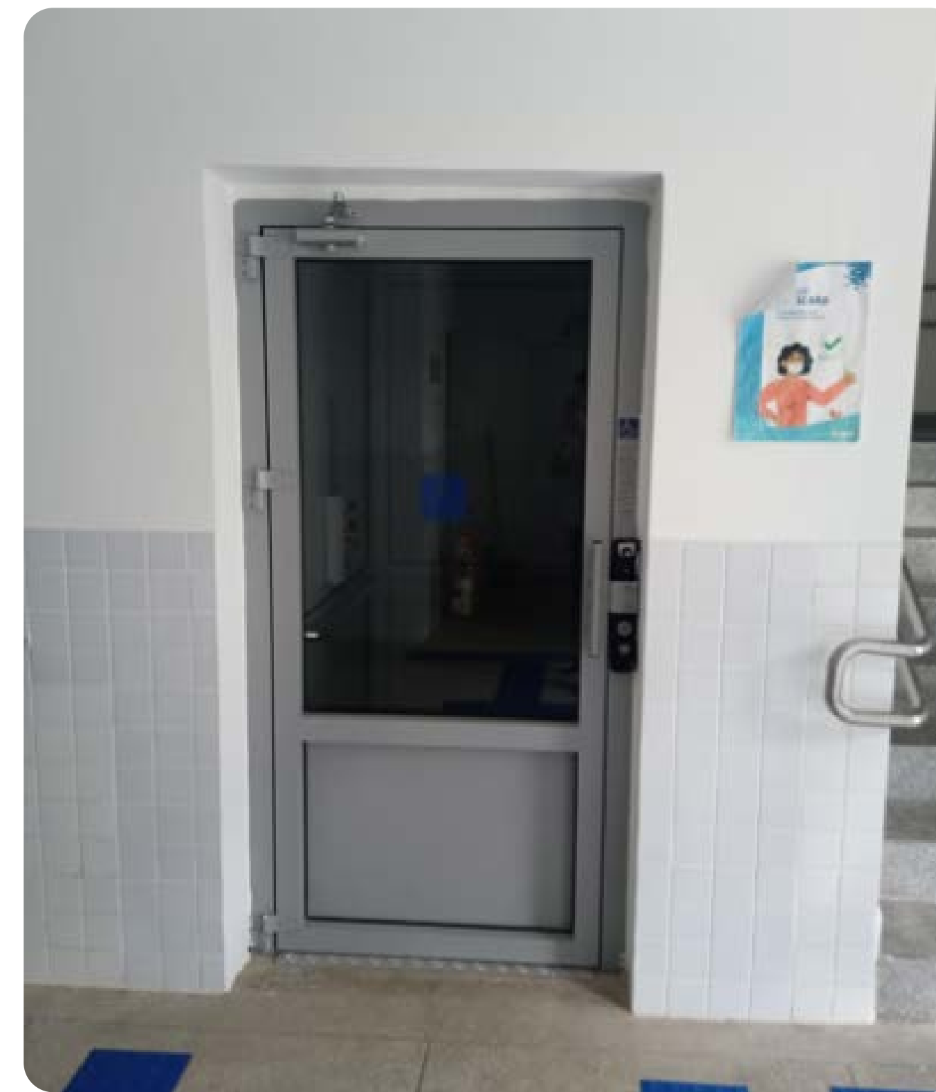
Figura 53 Instalação de Plataforma de acessibilidade no Campus de Pau dos Ferros.
