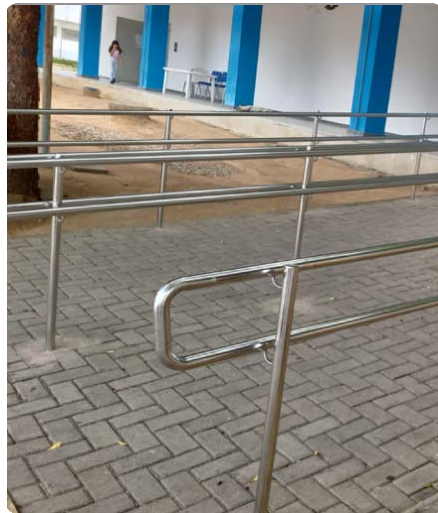
Figura 52 Instalação de corrimão em prédios no Campus de Caraúbas.
