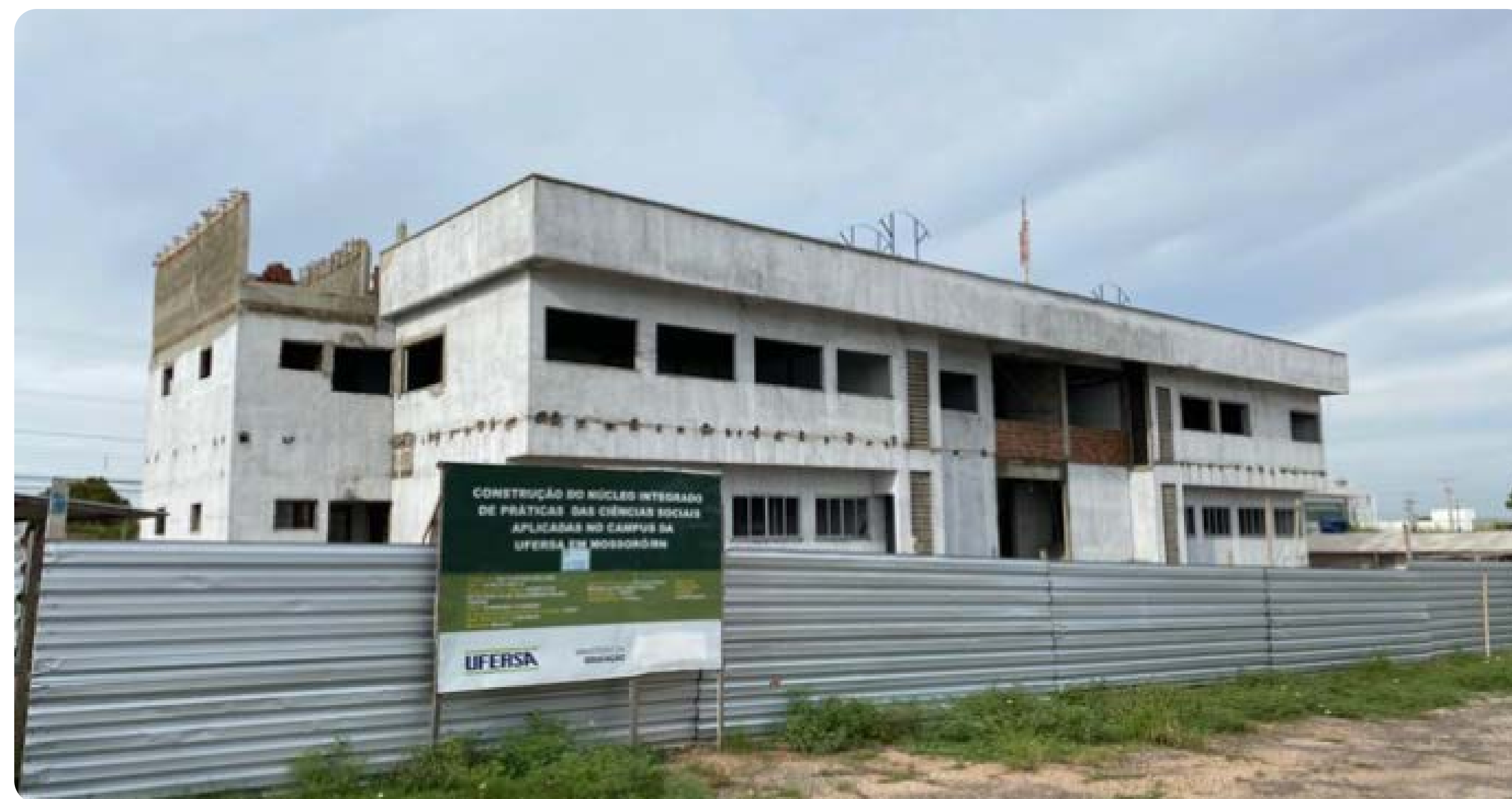
Figura 56 Núcleo Integrado de Práticas Sociais Aplicadas – em fase de conclusão.
