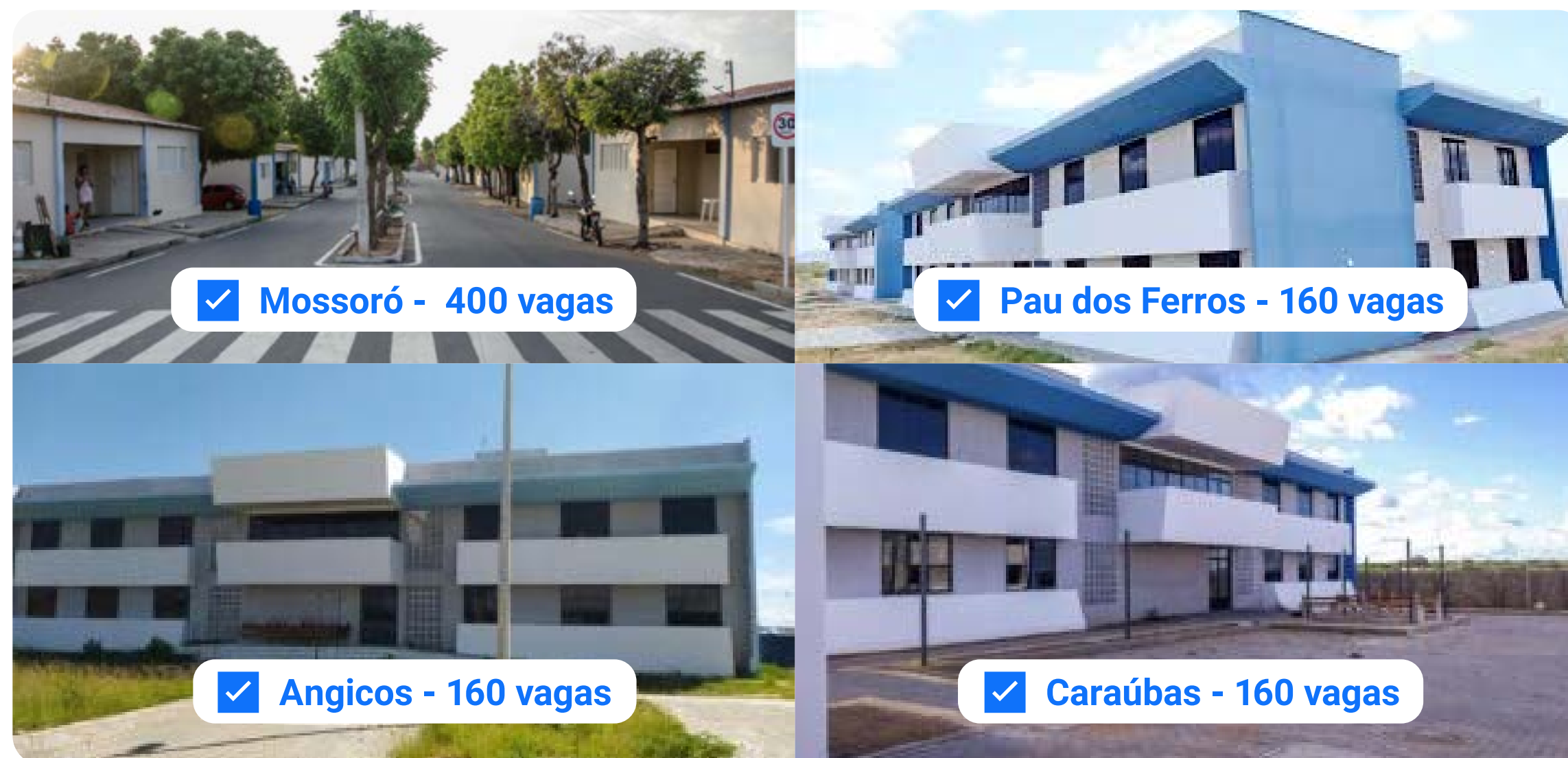
Figura 60 Imagens das moradias estudantis da Ufersa.
