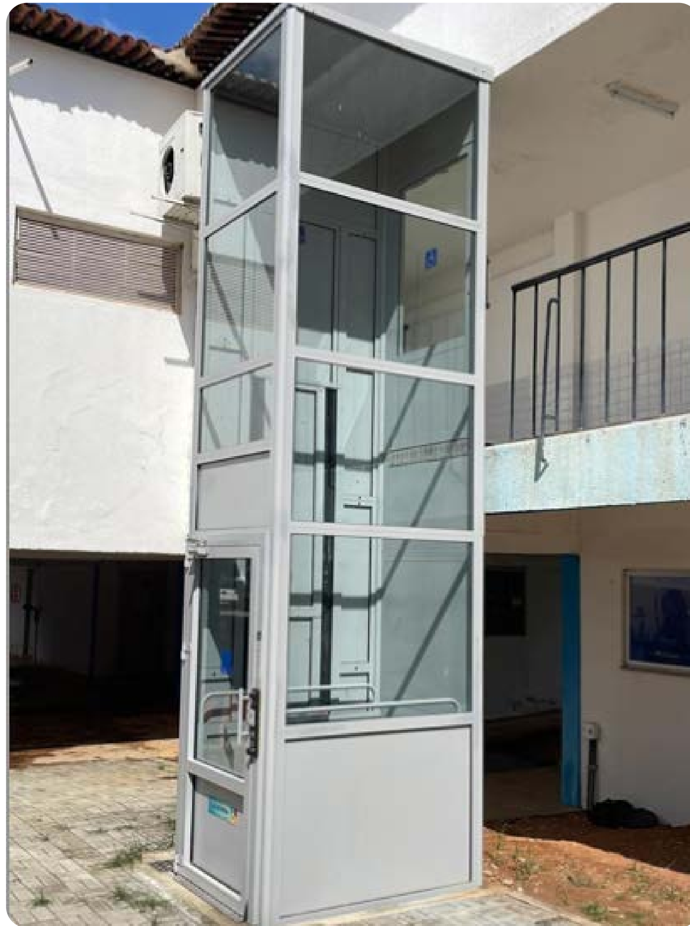
Figura 92 Instalação de Plataforma de acessibilidade no Prédio Central do Campus Mossoró
