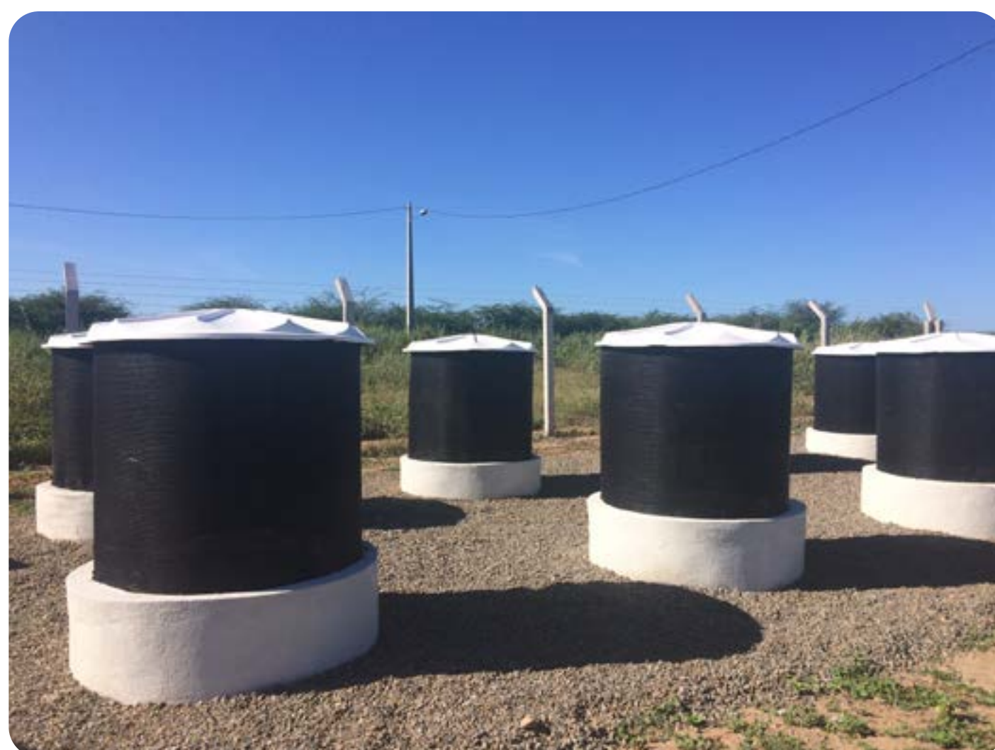
Figura 65 Usina de compostagem na UFERSA Campus Mossoró
