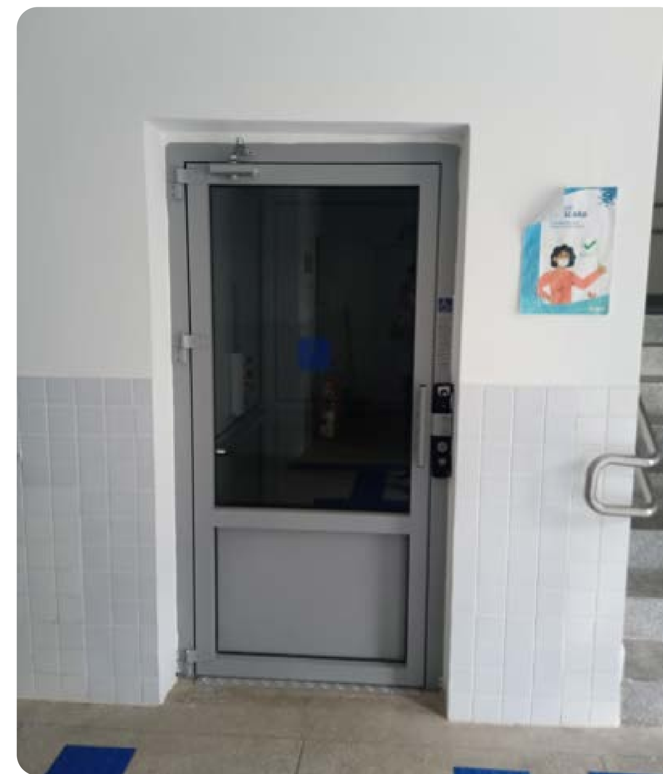
Figura 74 Instalação de Plataforma de acessibilidade no Campus de Pau dos Ferros
