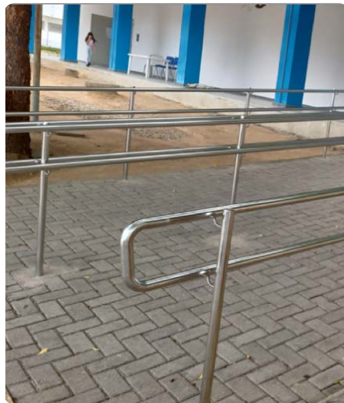
Figura 73 Instalação de corrimão em prédios no Campus de Caraúbas
