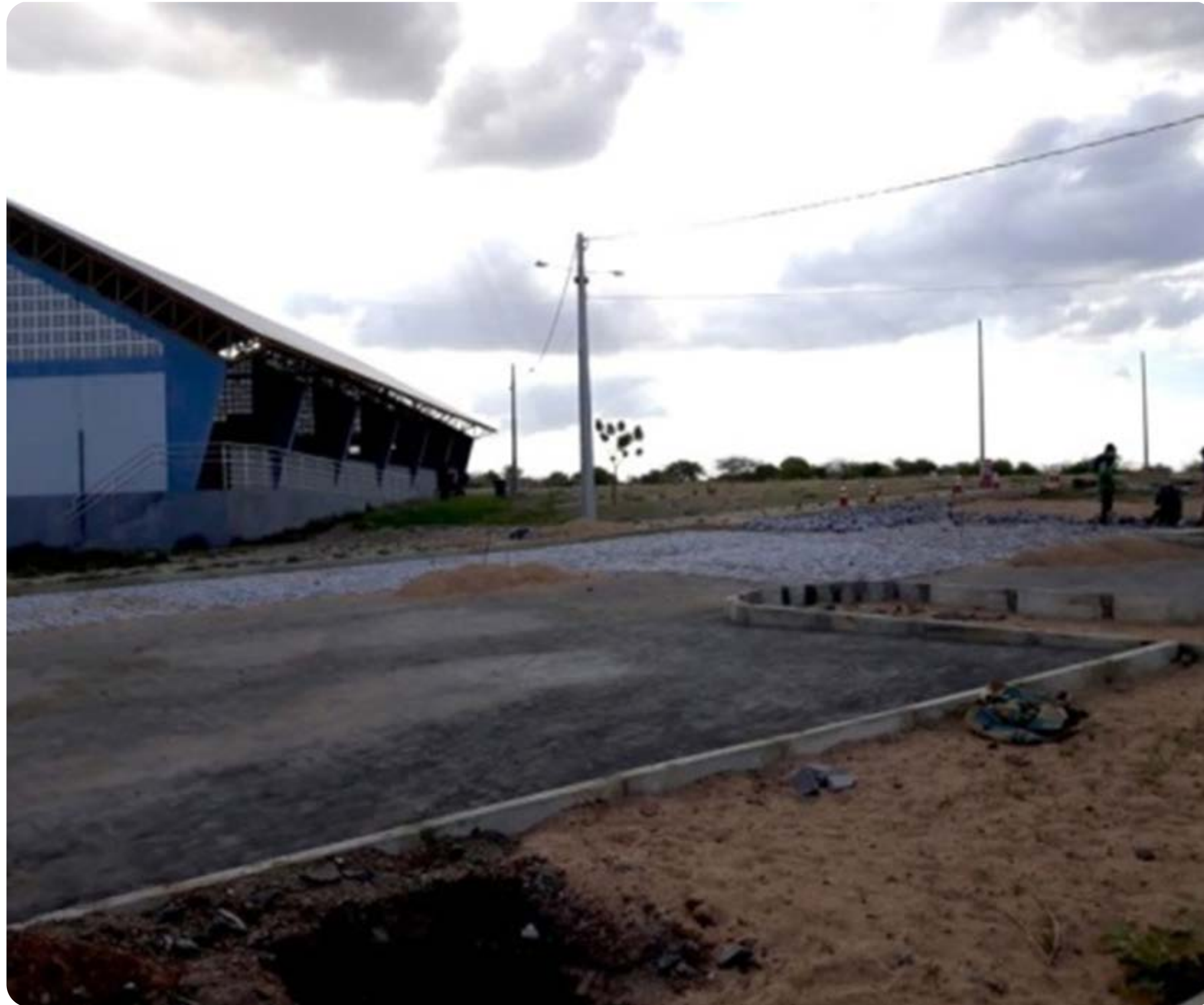
Figura 78 Serviço de urbanização de acesso à quadra poliesportiva no Campus Angicos
