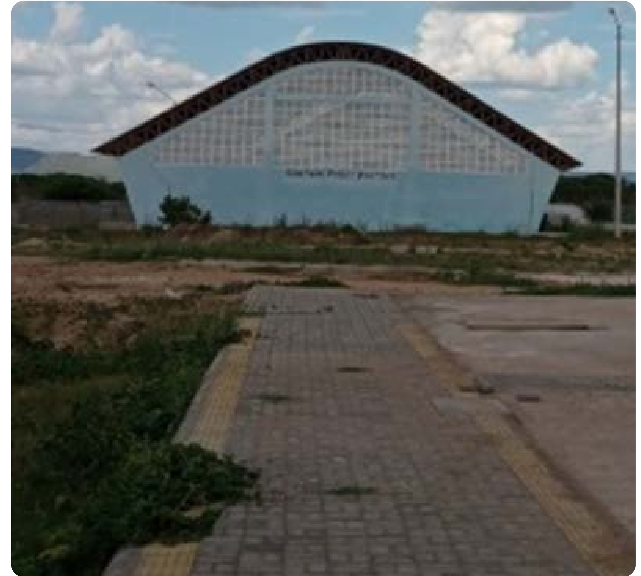
Figura 79 Serviço de urbanização de acesso à quadra poliesportiva no Campus Pau dos Ferros
