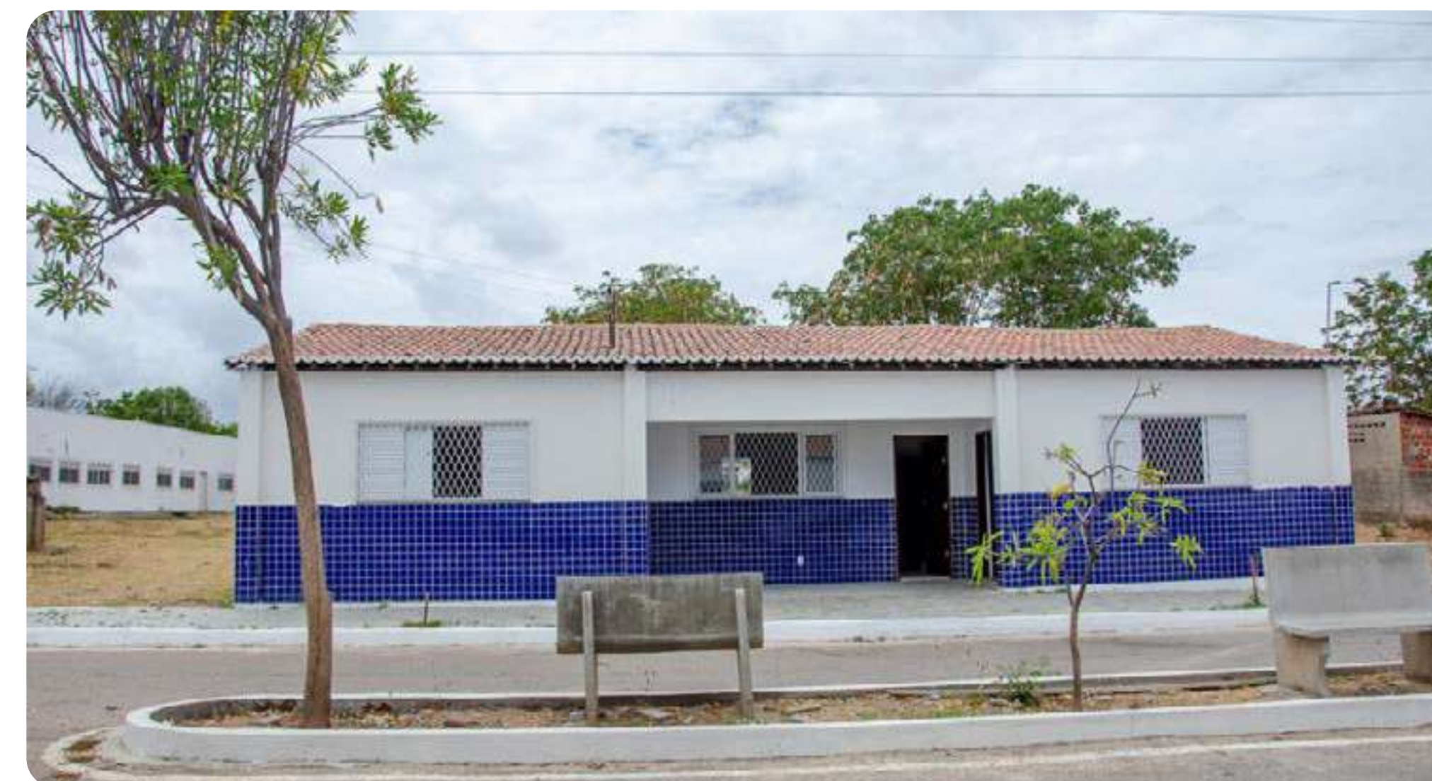
Figura 38 Reforma das casas da vila masculina no Campus Mossoró.
