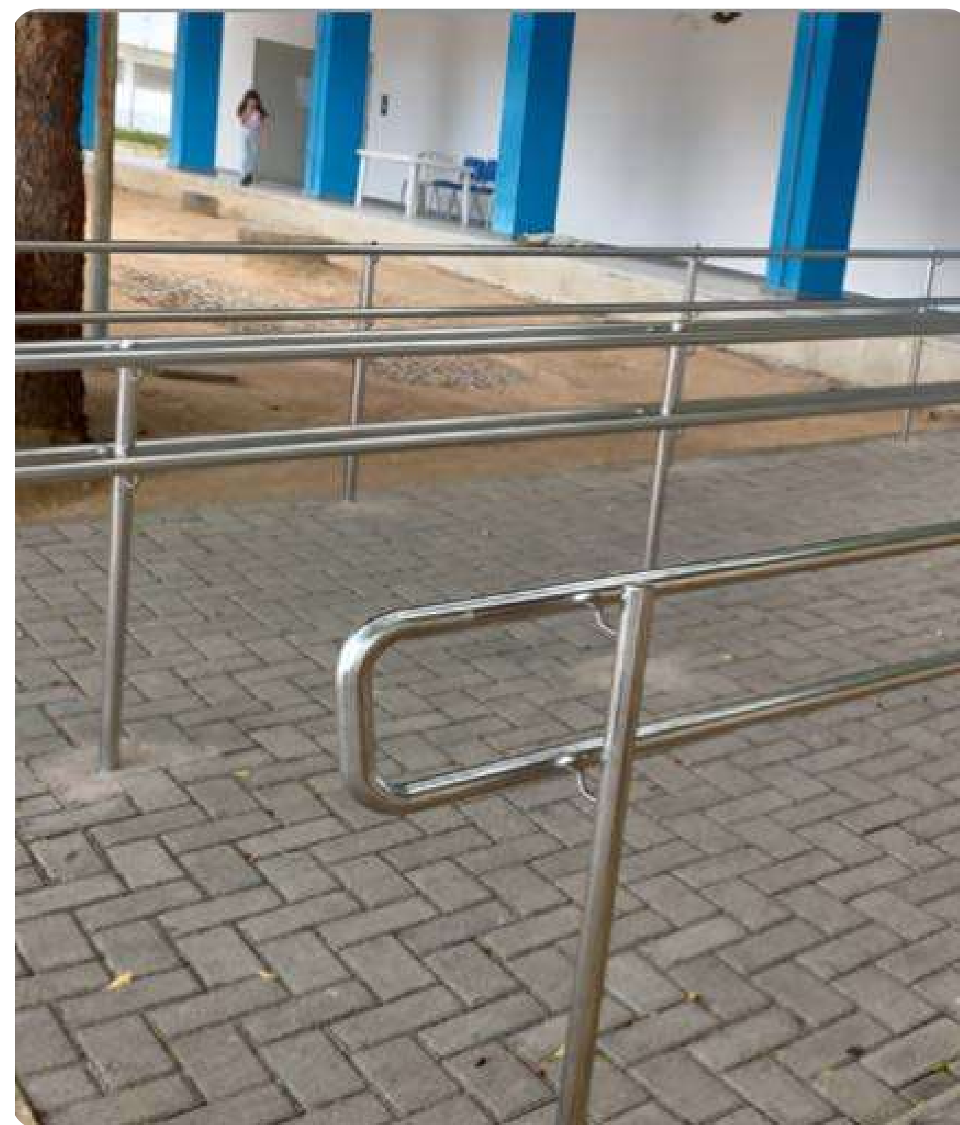
Figura 47 Instalação de corrimão em prédios no Campus de Caraúbas.
