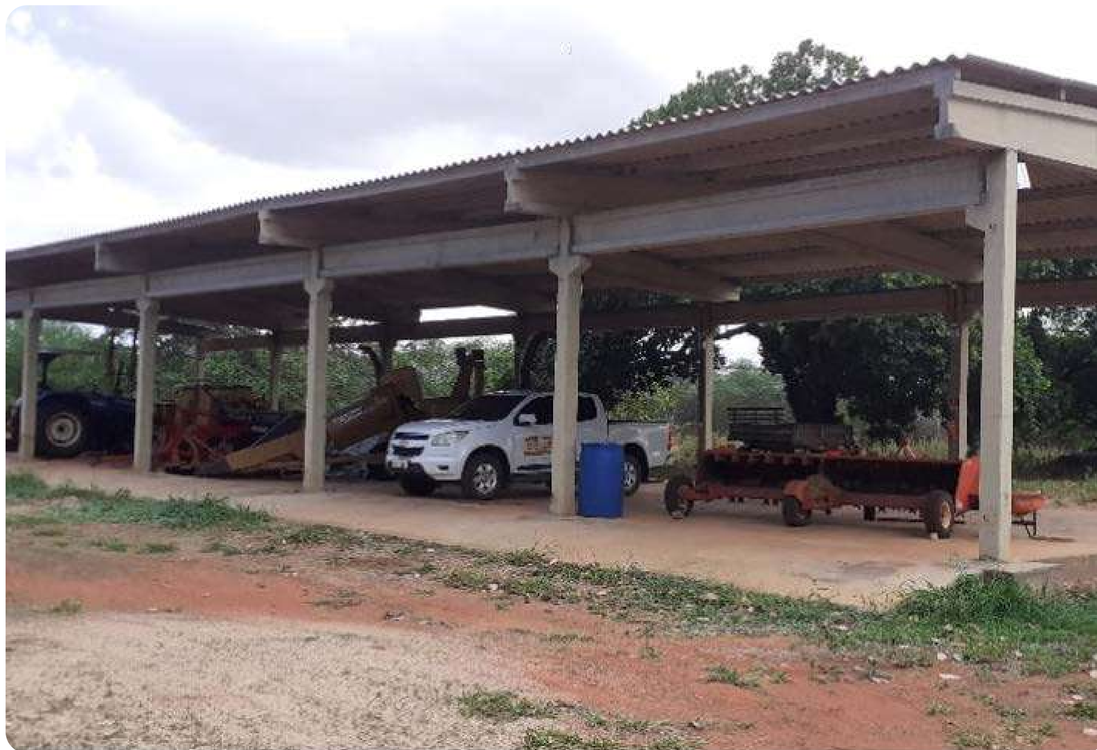
Figura 44 Galpão de Máquinas na Fazenda Experimental Rafael Fernandes.
