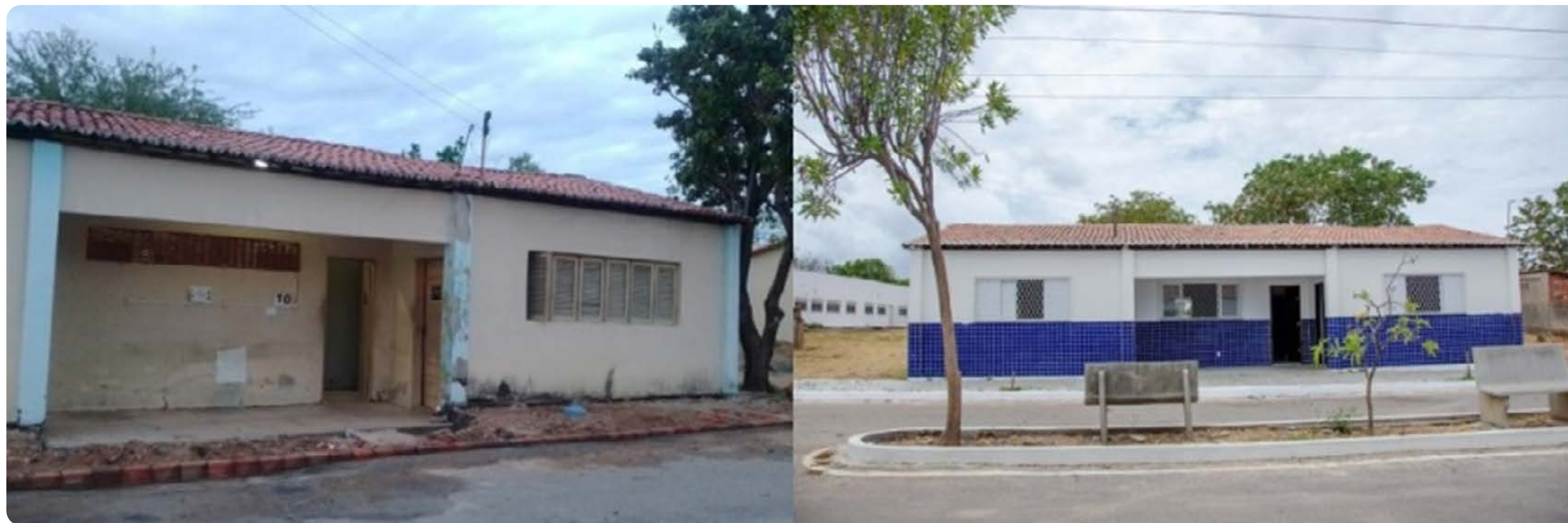
Figura 52 Antes e depois da Reforma da Vila Acadêmica Masculina, em Mossoró.
