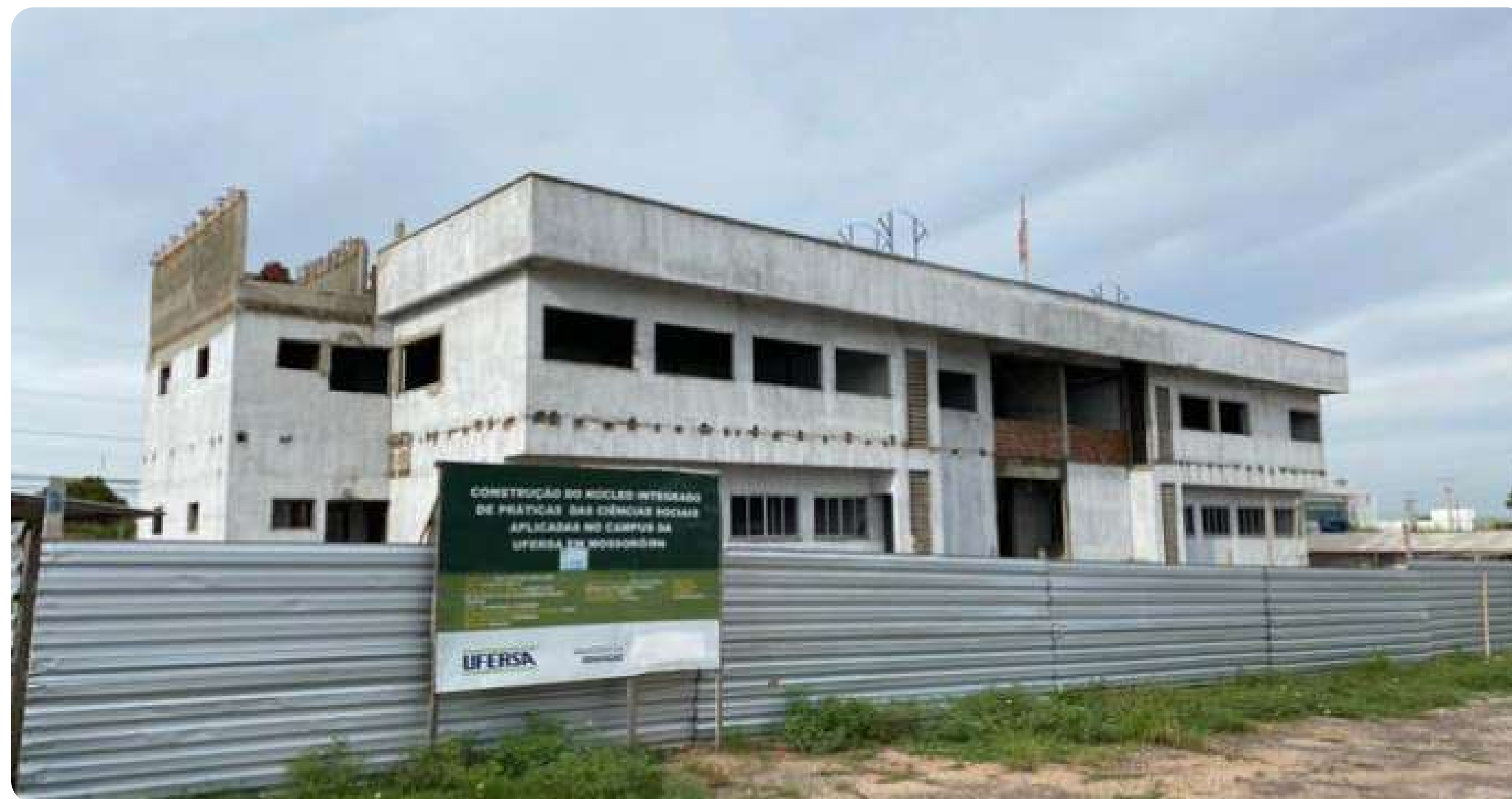
Figura 51 Núcleo Integrado de Práticas Sociais Aplicadas – em fase de conclusão.
