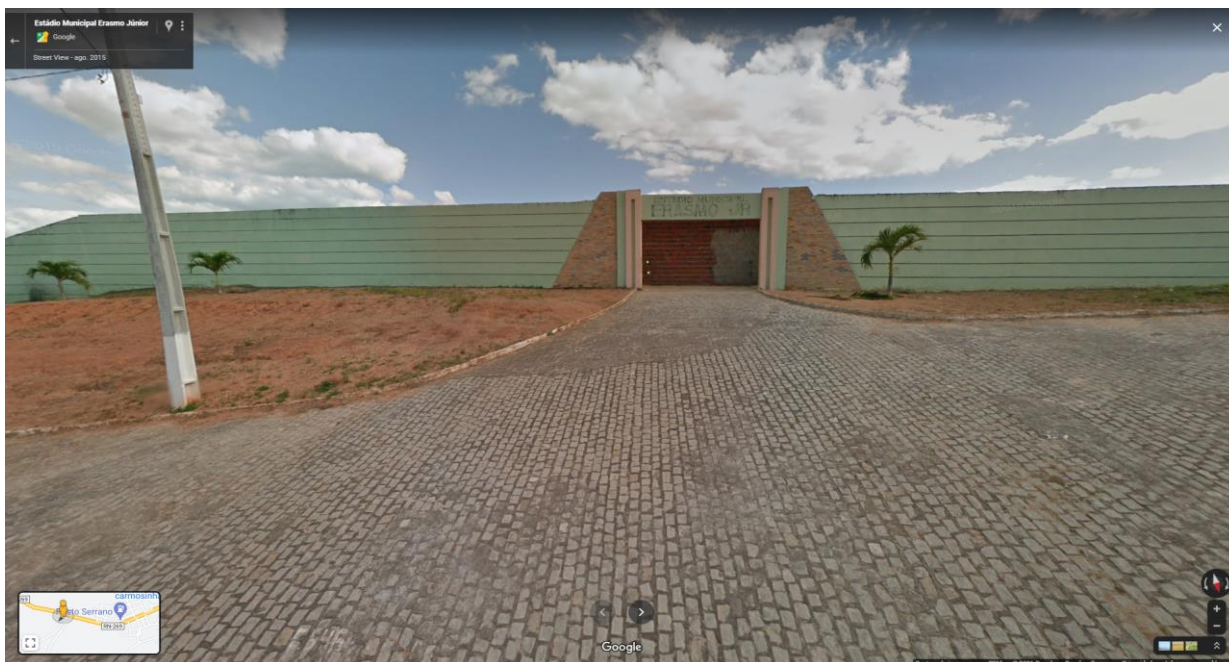
Figura 13: Muro da Frente do Terreno
