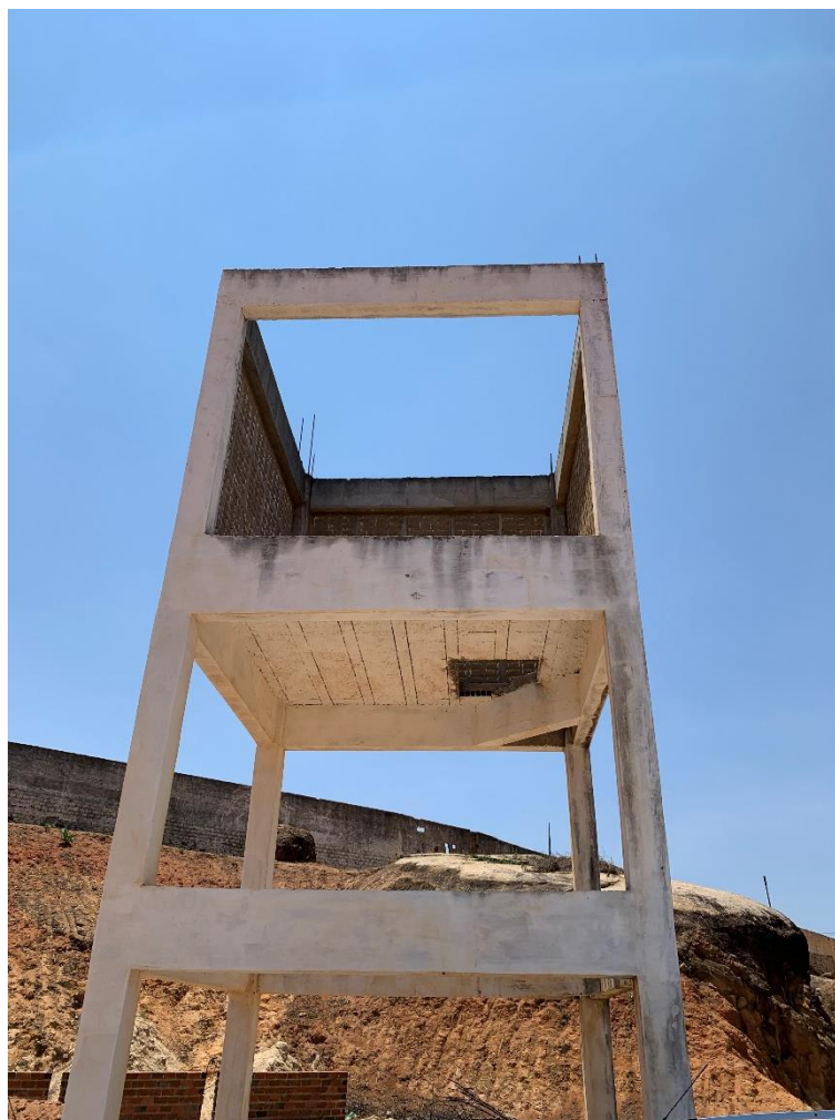
Figura 9 – Estrutura do reservatório de água fria superior.
