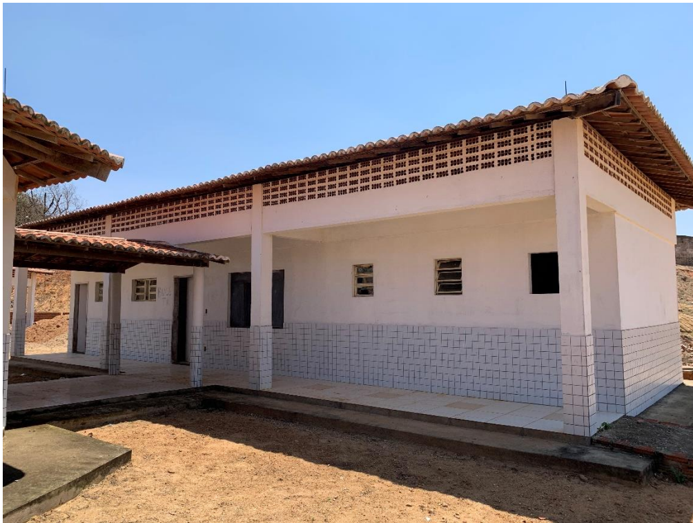
Figura 4 - Construção #2: Cozinha e banheiros.
