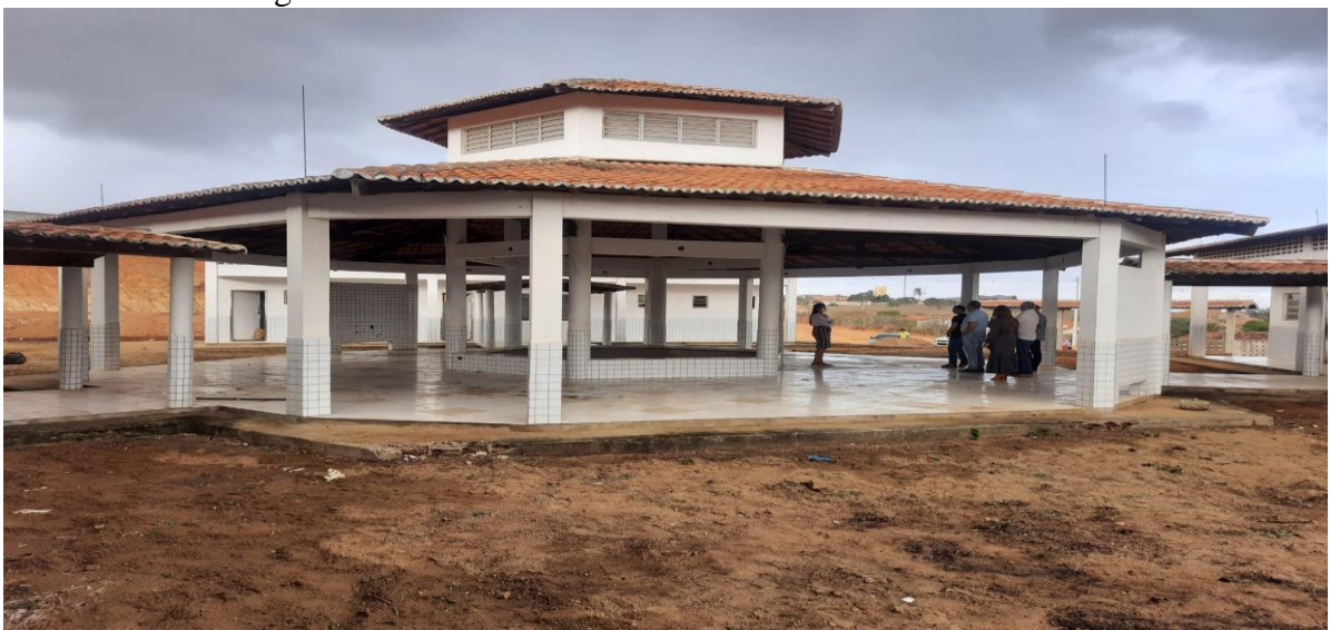
Figura 21: Pátio central da escola Fonte: Elaboração Própria.
