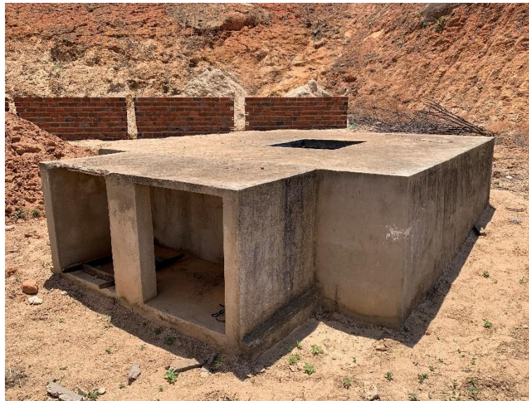
Figura 8 – Estrutura do reservatório de água fria inferior.
