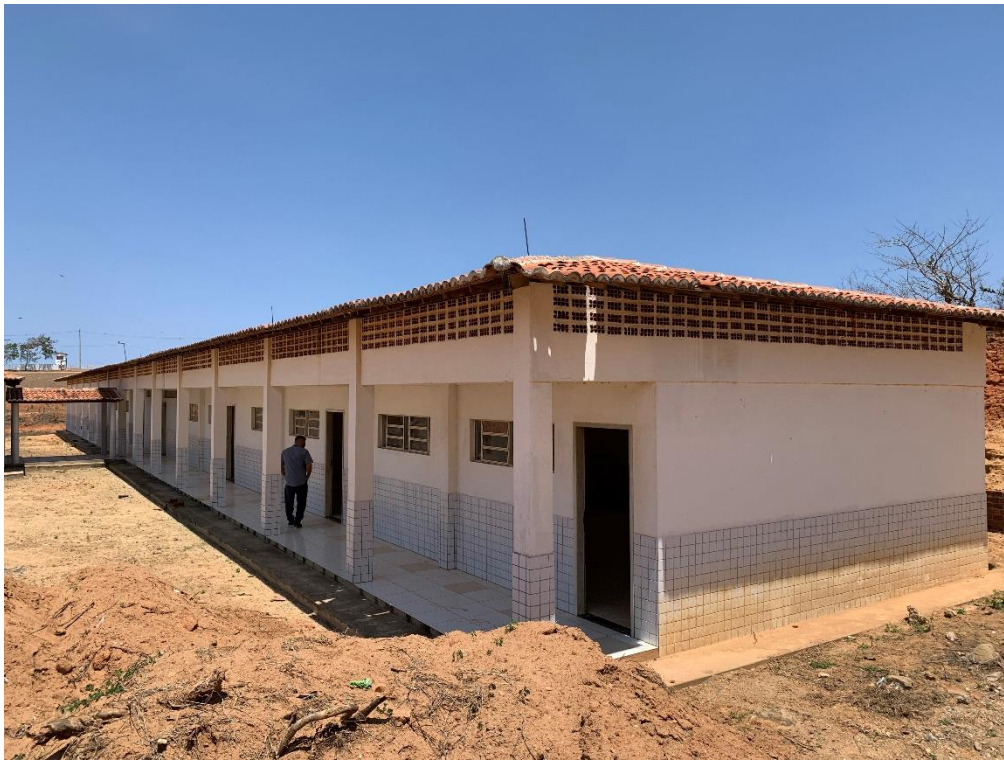
Figura 6 - Construção #4. Salas de aula.
