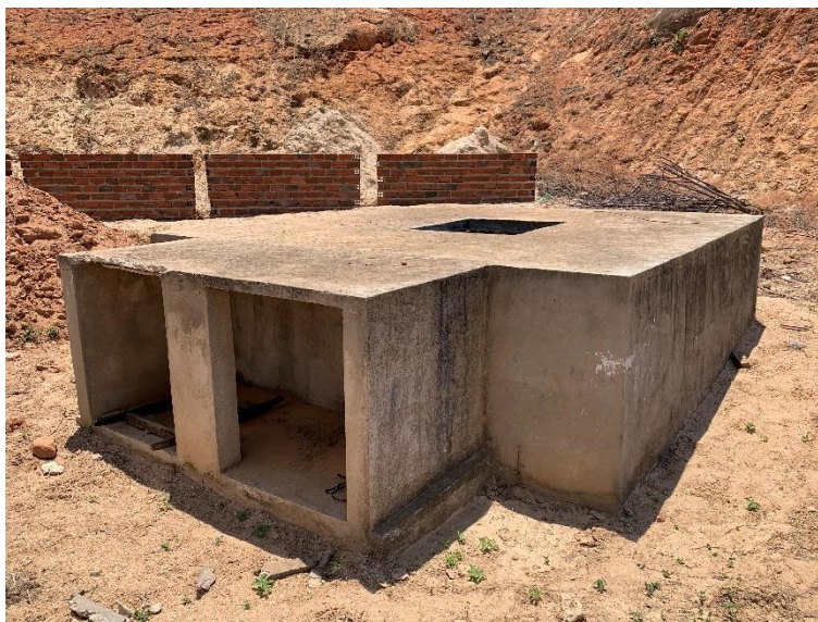
Figura 8 – Estrutura do reservatório de água fria inferior.
