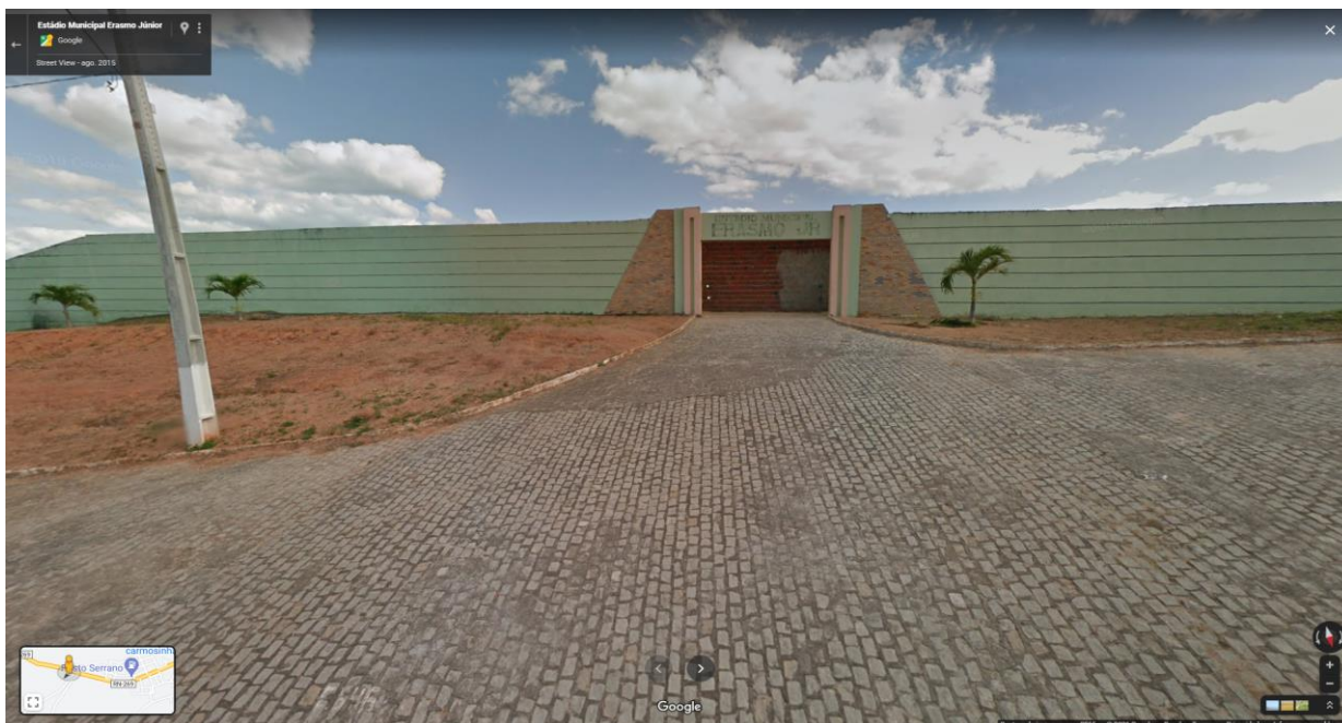
Figura 13: Muro da Frente do Terreno
