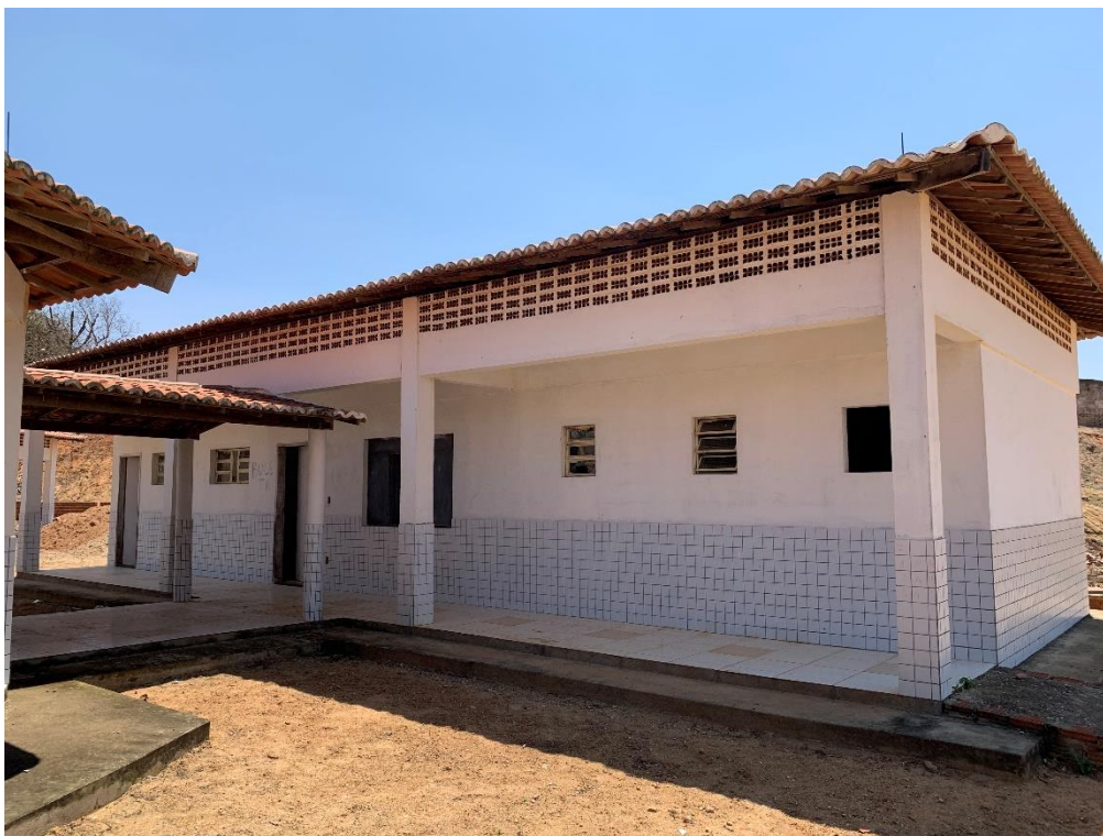
Figura 4 - Construção #2: Cozinha e banheiros.
