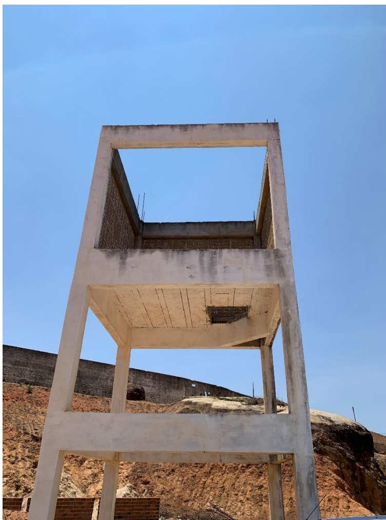
Figura 9 – Estrutura do reservatório de água fria superior.
