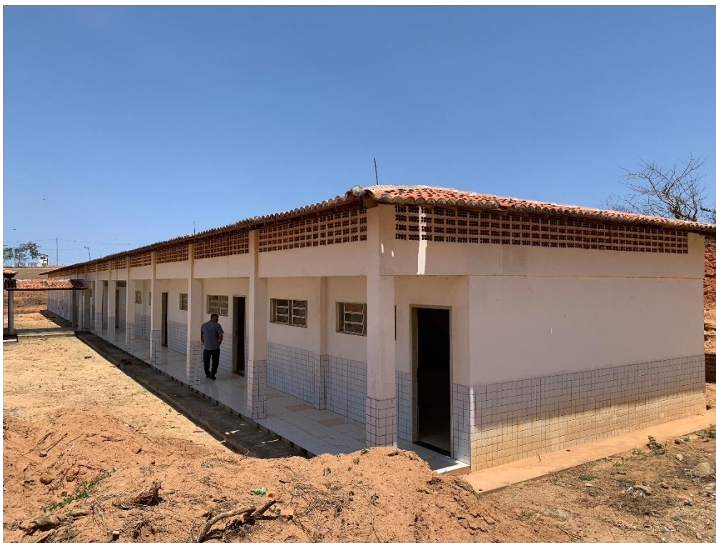
Figura 6 - Construção #4. Salas de aula.
